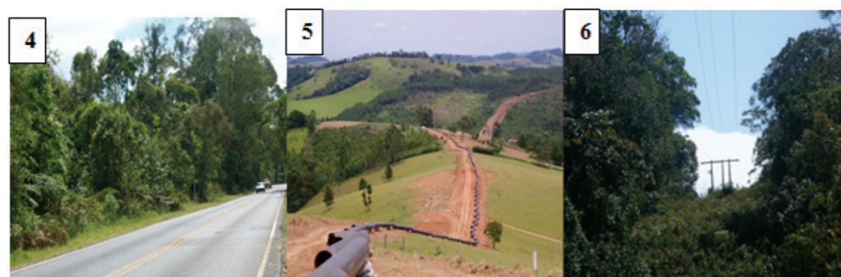
Foto 4: Rodovia MG 132; Foto 5: Oleoduto e Gasoduto; Foto 6: Rede de alta tensão da CEMIG.
